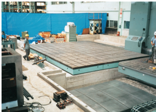
▲9分通り完成したフロー一定盤 (8m×6m) 2,000×4000 6台使用 Above photo shows the scene of setting work of 8m×6m floor plates (use 2m×4m plates)
